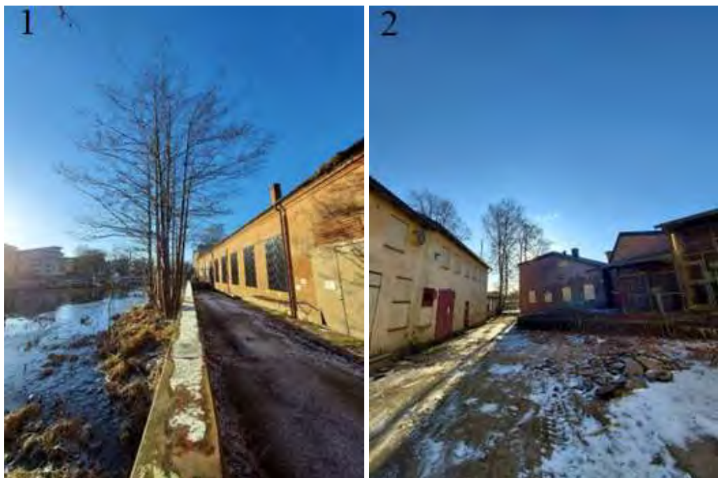
Figur 3: Bild 1 närmst Lagan, sett från norr mot söder. Bild 2 sett från väst mot öst och Lagan, mellan nu befintliga byggnader planerade att rivas samt De tre skeppen .
