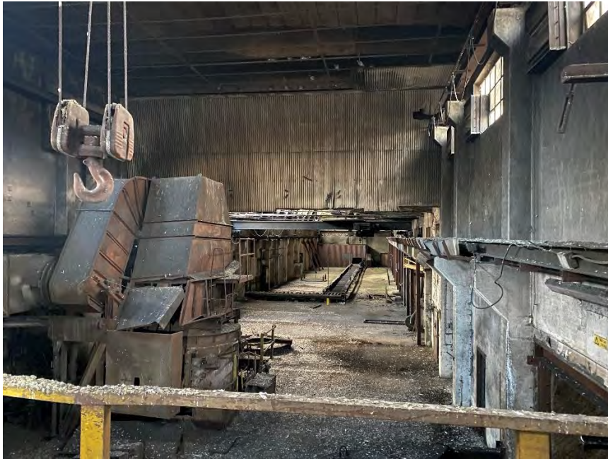
Bild på byggnadens inre skick. På bilden syns den gamla smältugnen och avgjutningsbanan.
