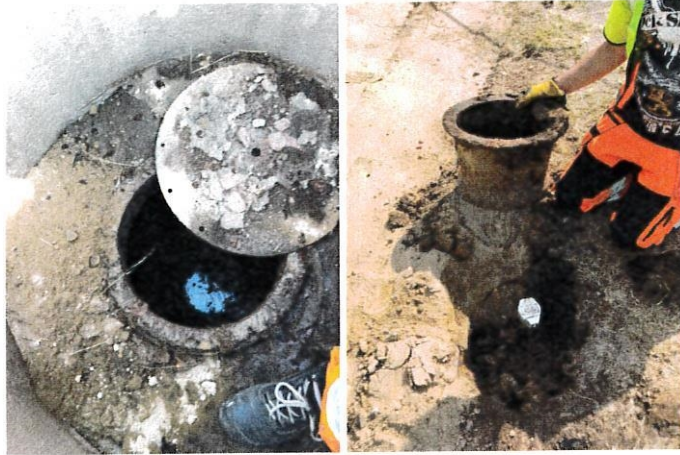
Figur 15. Lock till vad som bedömts vara en diesel- eller fotogentank till vänster samt till höger lock till påfyllnadsledning eventuellt kopplad till nämnd tank.
