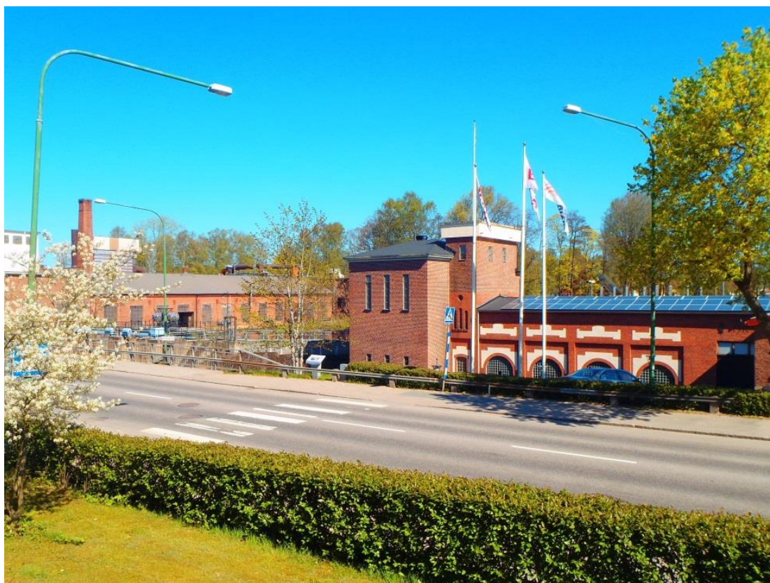
Nya solcellsanläggningen på taket till vänster, kraftverksbron i Ljungby
