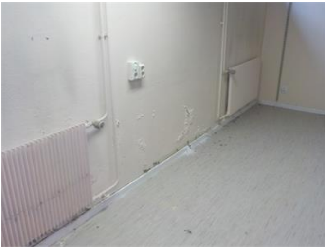
Bild på strykrum i den östra delen av källaren.
