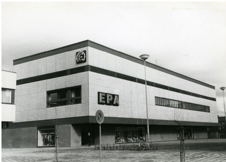
EPA-varuhuset i kvarteret Månen nybyggt 1966.
