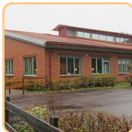
EKEBACKENSKOLAN 254 elever åk F-6 Teknisk status 8 poäng Delvis ändamålsenlig Lokalunderskott
