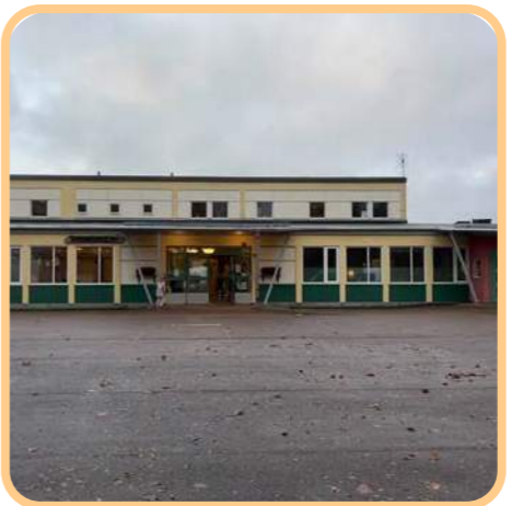
RYSSBYSKOLAN 121 elever åk F-6 Teknisk status 6 poäng Delvis ändamålsenlig Lokalunderskott
