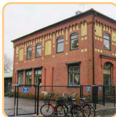
FOGDEGATANS FÖRSKOLA 2 avdelningar och 40 barn Teknisk status 6 poäng Delvis ändamålsenlig Verksamheten anser: Ej ändamålsenlig Framtida kapacitet: 2 avd 40 barn
