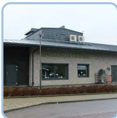
KLÖVERÄNGENS FÖRSKOLA 8 avdelningar och 114 barn Teknisk standard 10 poäng Ändamålsenlig Framtida kapacitet: 8 avd 100 barn
