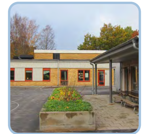
BERGALYCKANS FÖRSKOLA 10 avdelningar och 132 barn Teknisk status 10 poäng Ändamålsenlig Framtida kapacitet: 10 avd 140 barn
