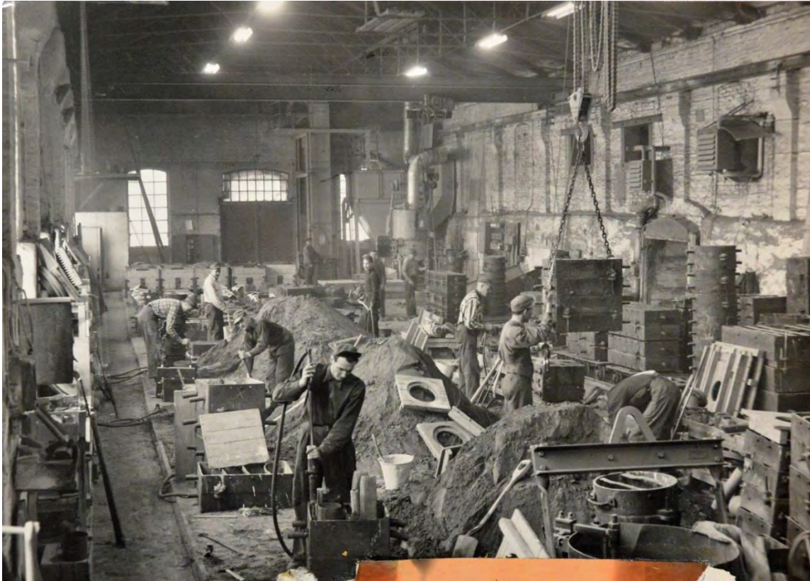
Bild från den äldsta hallen. Här förbereds gjutformar vilket innebär att stora mängder sand ständigt måste finnas tillgängligt. Med tanke på fönstren i bakgrunden bör bilden kunna dateras till 1950-tal. Verksamheten var helt beroende av ett fungerande system av lyftanordningar. Ljungby kommunarkiv
