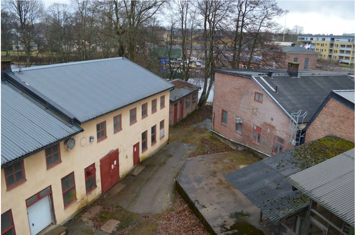
Fasader, fönster och tak är generellt i mycket gott skick.
