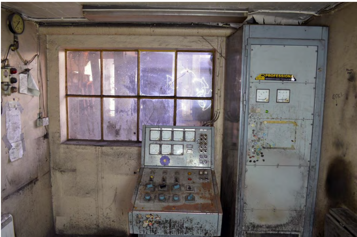
Delar av smältugnens bevarade kontrollrum. Bakom fönstret anas ugnen.
