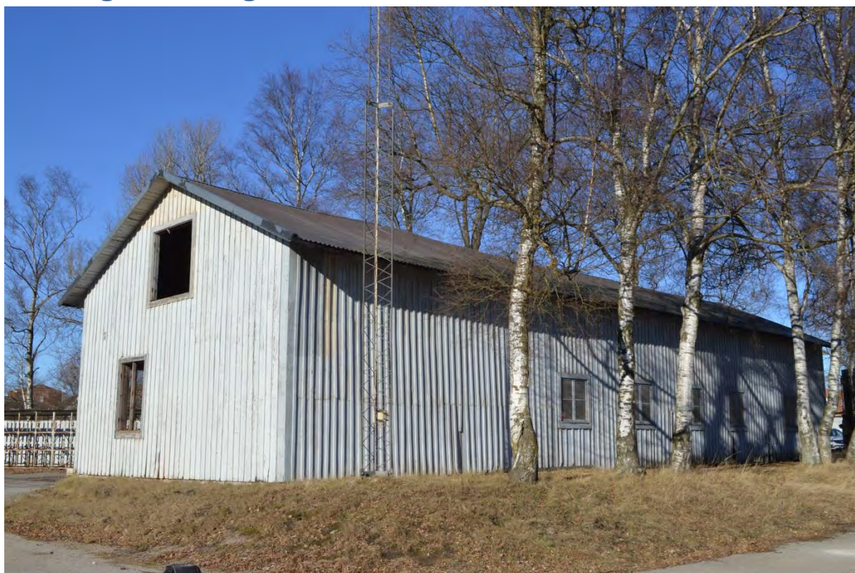
Magasinets täckta östsida med traditionell locklistpanel.
