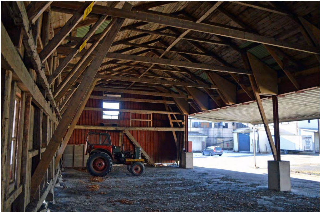
Bild tagen mot sydväst där den stora öppningen blir tydlig samt vilka järn- och träförstärkningar som krävdes för att klara tillkomna laster. En trappa leder upp till ett mindre loft.
