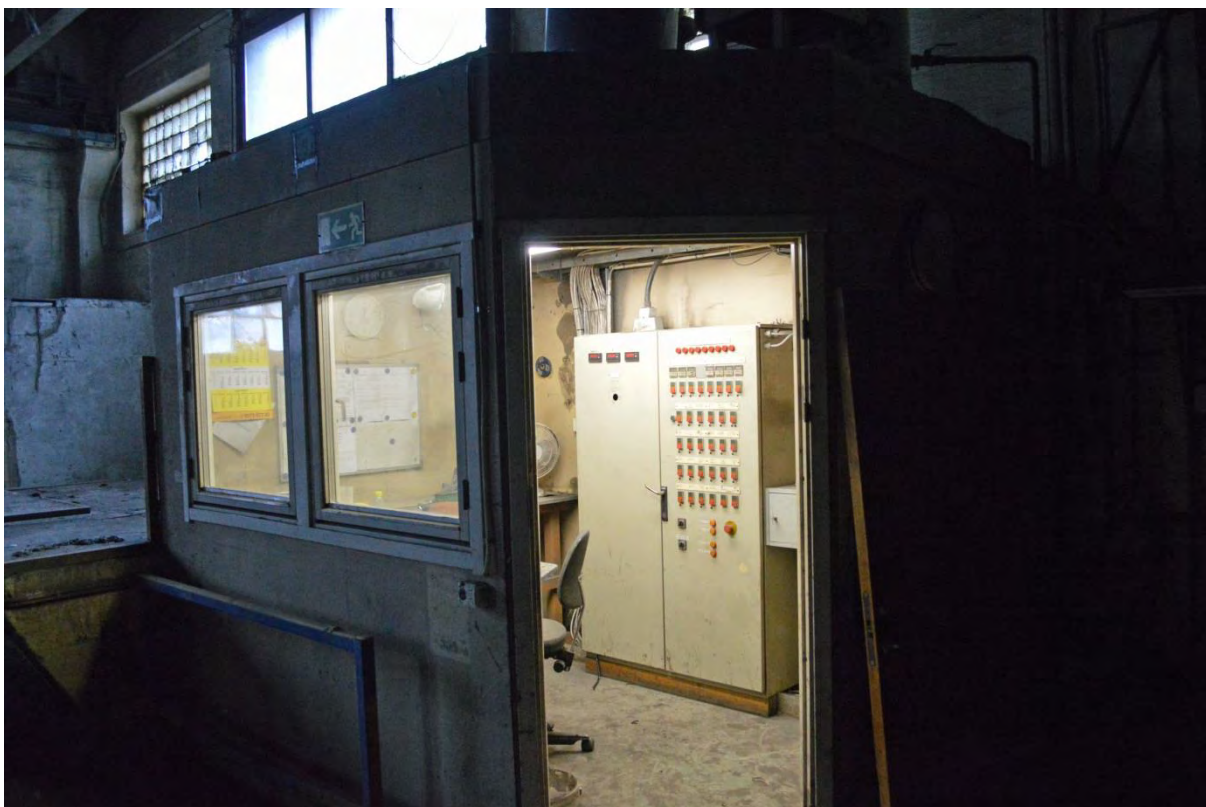
Mindre kontor i anslutning till sandsilotornet med en stor kontroll/styrpanel avsedd för en rad skilda funktioner kopplade till sandhanteringen och dess transportsystem.
