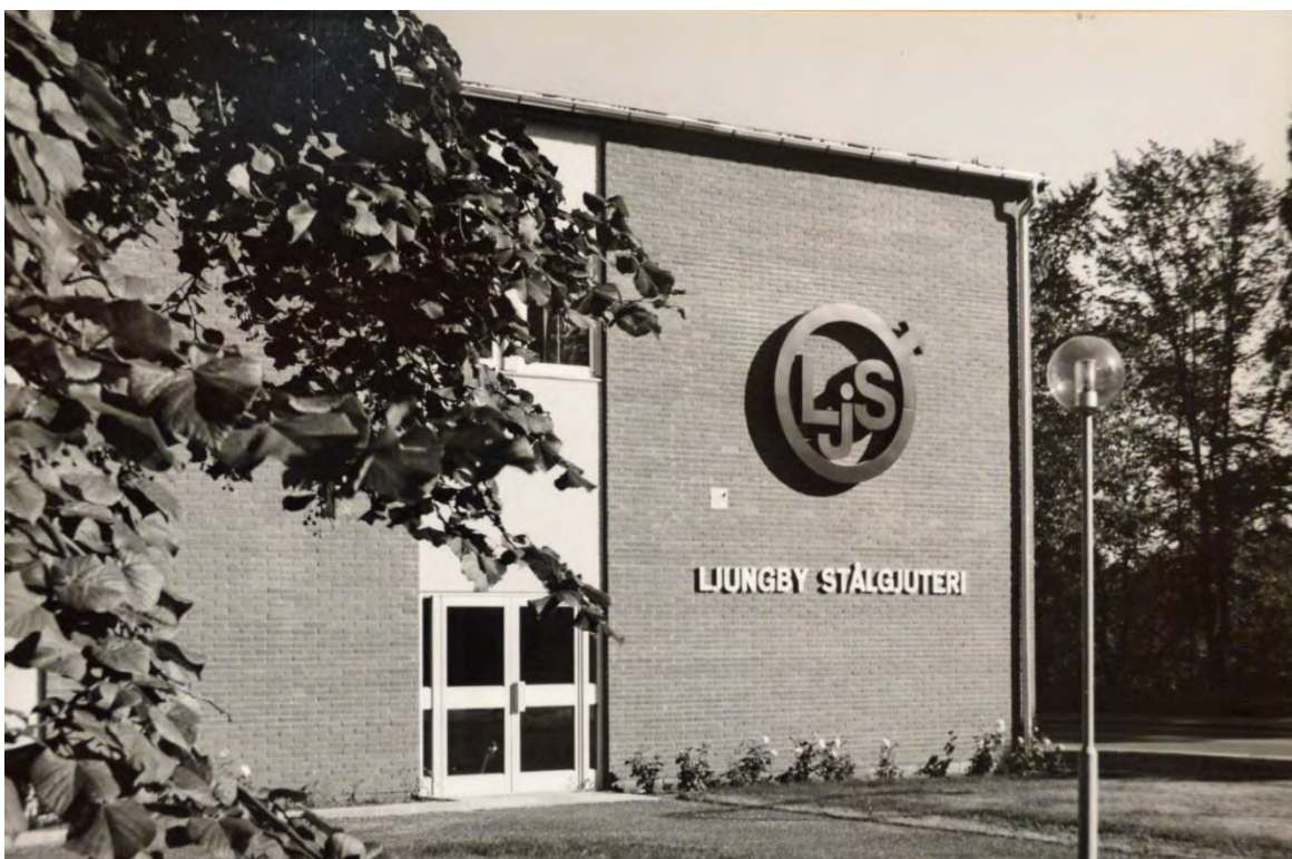
Entrén till nya personalbyggnaden från 1978, bilden är tagen 1985. Till höger anas Storgatan. Fasadtegel lagt med löpskift samt svagt insjunkna väggpartier av cementplattor med friliggande ballast. Foto: Studio Lennart AB, Ljungby kommunarkiv
