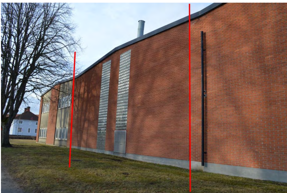
Fasad mot Storgatan. Den högra markeringen visar mötet mellan 1962 och 1972 års skepp. Vänster markering tydlig motsvarande möte med 1978 års personaldel. Intentionen vid utbyggnaderna har varit att nyttja tegel samt betongglas för att erhålla en sammanhållande fasadkaraktär. Frostsprängt tegel förekommer i högst begränsad omfattning.
