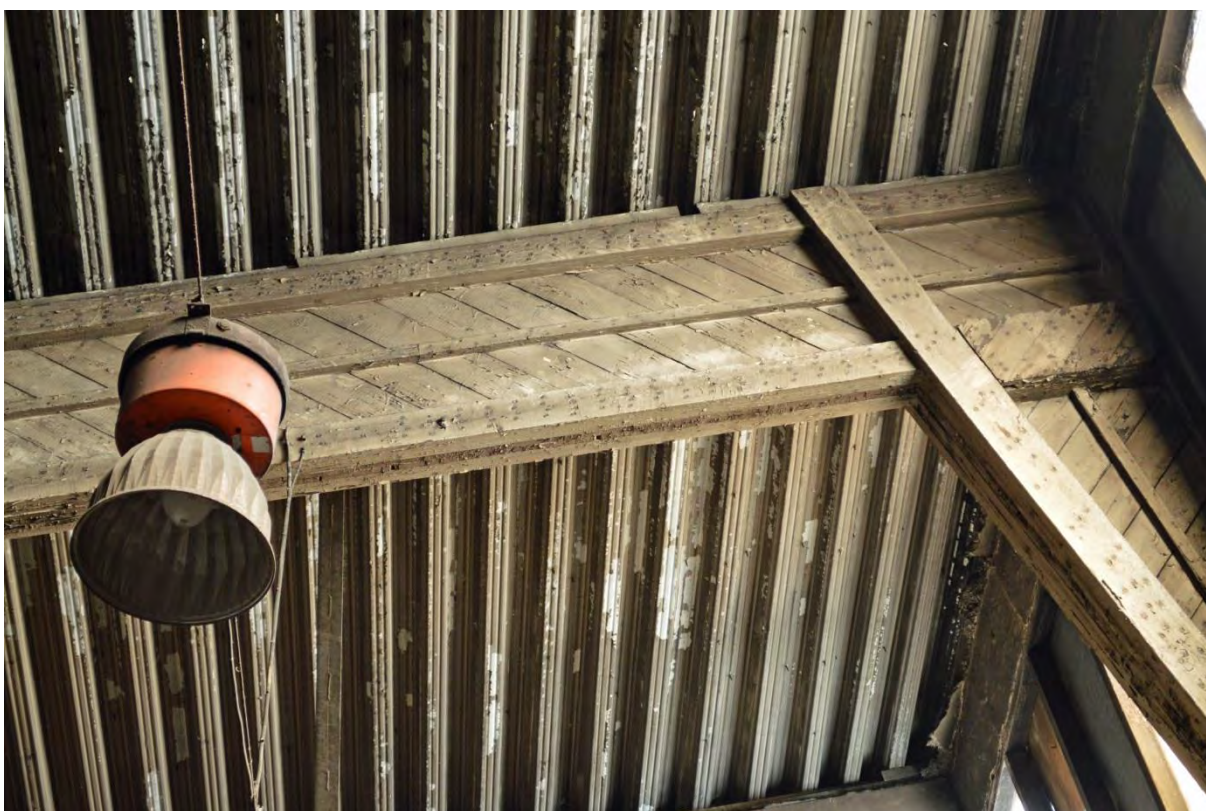
Närbild på HB-balk i västra skeppet. En speciell balkkonstruktion framtagen i början av 1940-talet bestående av inbördes hoplimmade och längdskarvade bräder.
