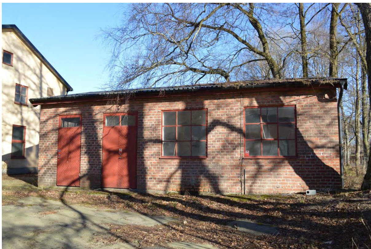
Långsida mot väster. Hängrännan är full med löv och grenar. I övrigt är exteriören i mycket gott skick.
