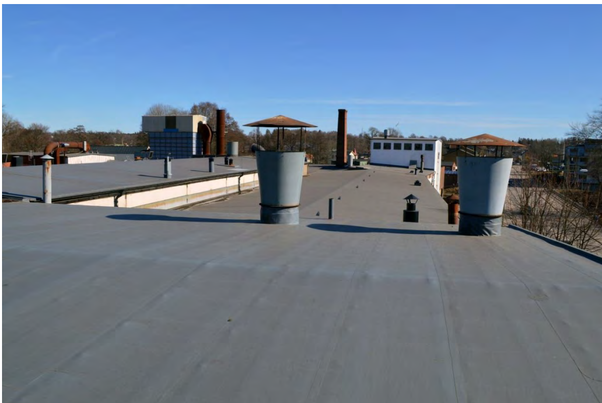
Bild tagen från 1962 års skepp mot sandsilotornet. Taktäckningen, Sarnafilduk, lades 1992 och är överlag i mycket gott skick. Närmast syns två ventilationshuvar
