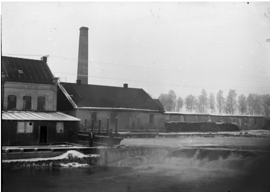
Den gamla kvarnen i trä ersattes efter branden av en rejäl tegelbyggnad (längst till vänster). Till höger syns resterna av grynfabrikens bottenvåning. Troligtvis revs väggarna och en ny tegelstomme restes för gjuteriet. Däremot återanvändes delar av stenfoten. Den gamla skorstenen utgör såväl blickfång som fast riktmärke när positioner och bildvinklar ska avgöras. Ljungby kommunarkiv
