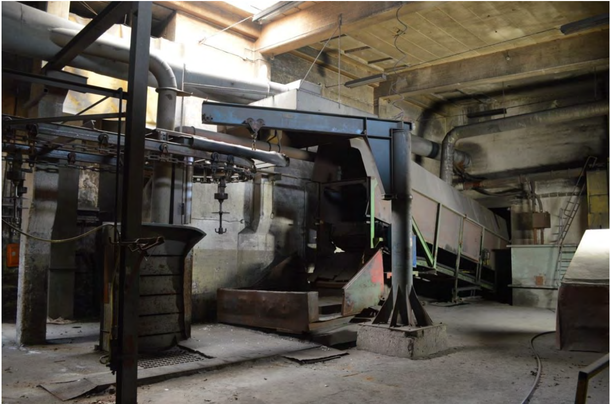
Hit kommer gjutgodset efter urslagning på ett transportband. Godset krokas därefter fast och transporteras via conveyerbanan för kylning och vidare behandling.
