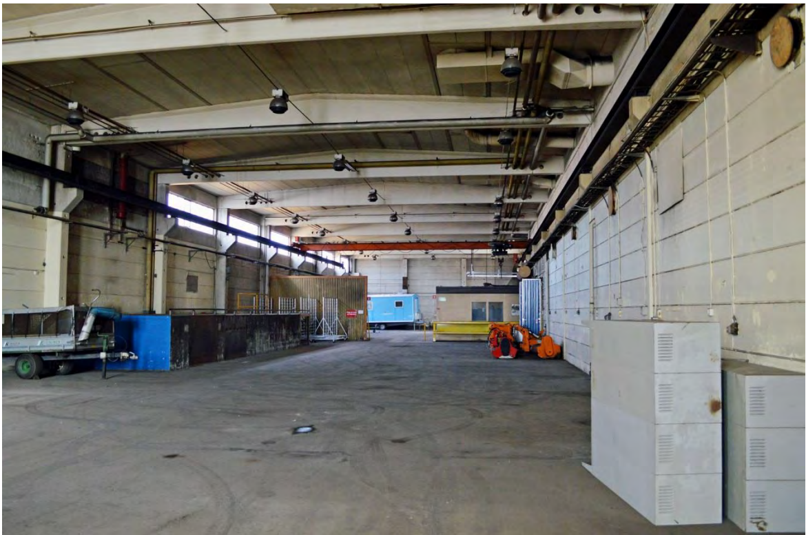
Skepp från 1972 som ursprungligen innehöll det nya skalgjuteriet. Utrymmena använts numera till förråd av kommunen.
