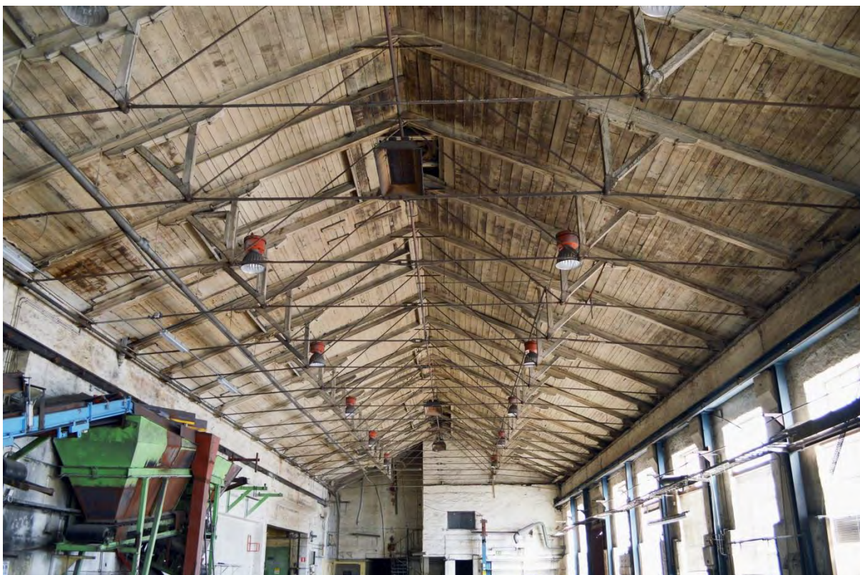
Den smäckra takkonstruktionen i skepp I med tillhörande armatur och gasolvärmare. Spiraltrappan i mitten går till kontors- och personalutrymmen.
