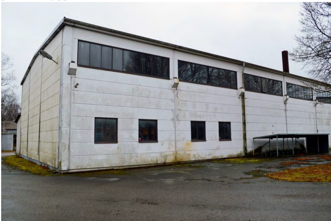
Norra änden på 1972 års skepp som förlades längsmed Fogdegatan. Här har betongelementen lämnats oinklädda och dekorativa inslag saknas helt. Fönsterbågar av trä. Elementskarvarna täcks med plåtprofiler.
