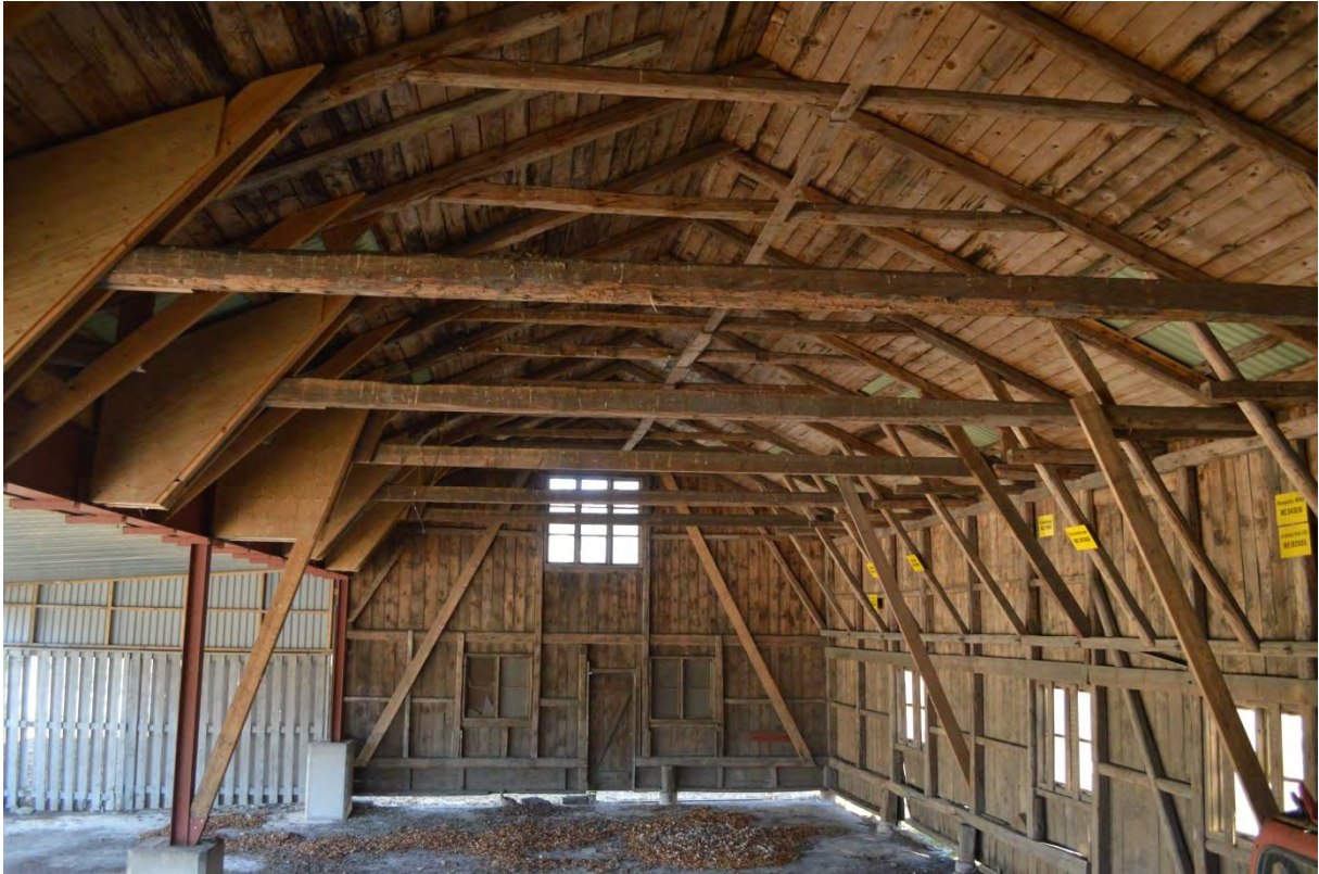
Bild tagen mot norra gaveln. Takkonstruktionen är både vacker och välgjord. Äldre taköppningar är numera igensatta.
