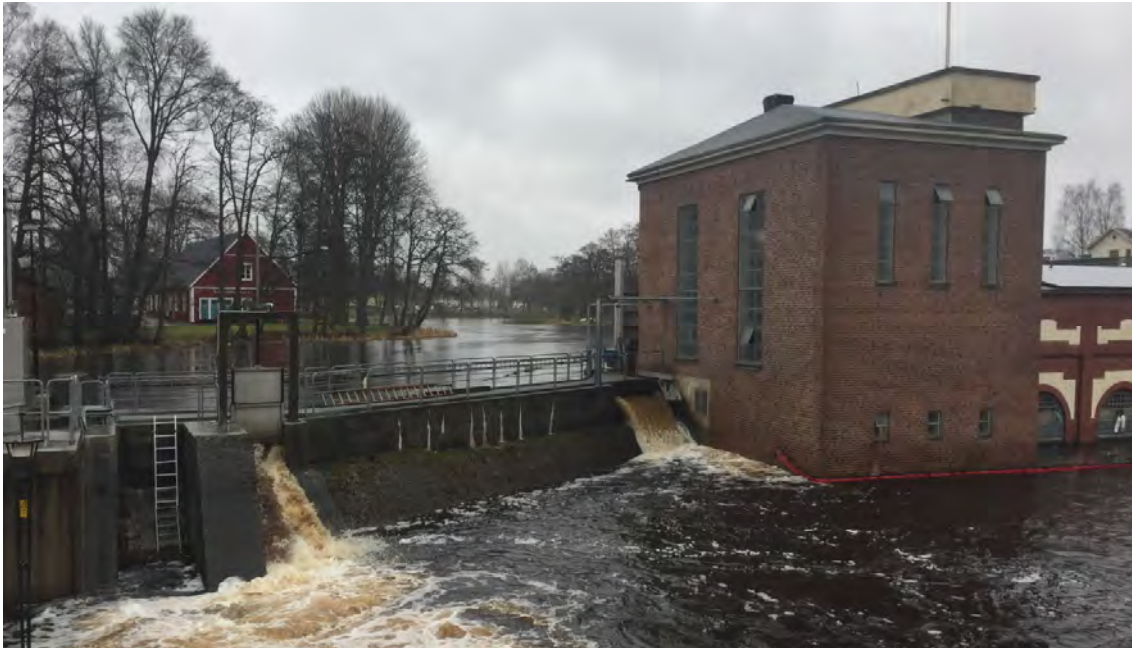
Figur 3. Ljungby vattenkraftverk sett från väster.
