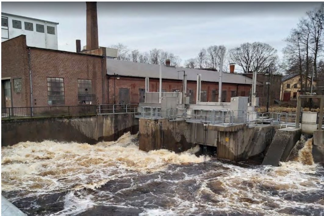
Figur 2 Ljungby Energi AB Vattenkraftverk. Bildkälla: Google Maps.
