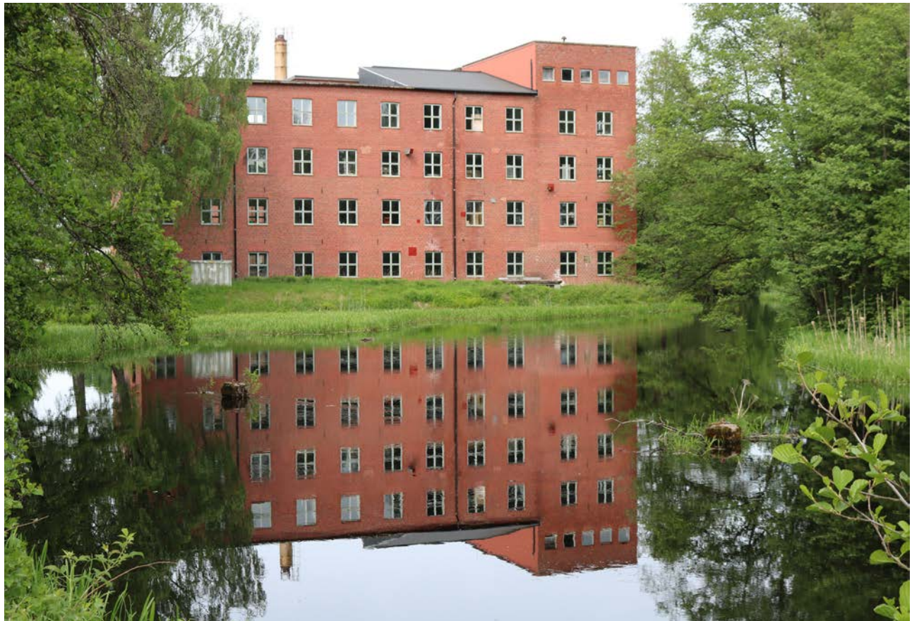
Fabrikernas fasader mot Skålån är präglad av expansionen under 1930-50-talet då verksamheten expanderat.
