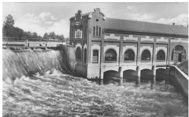
Kraftverket vid Lagaån fotograferat på 1920-talet. Foto: Tekniska museet
