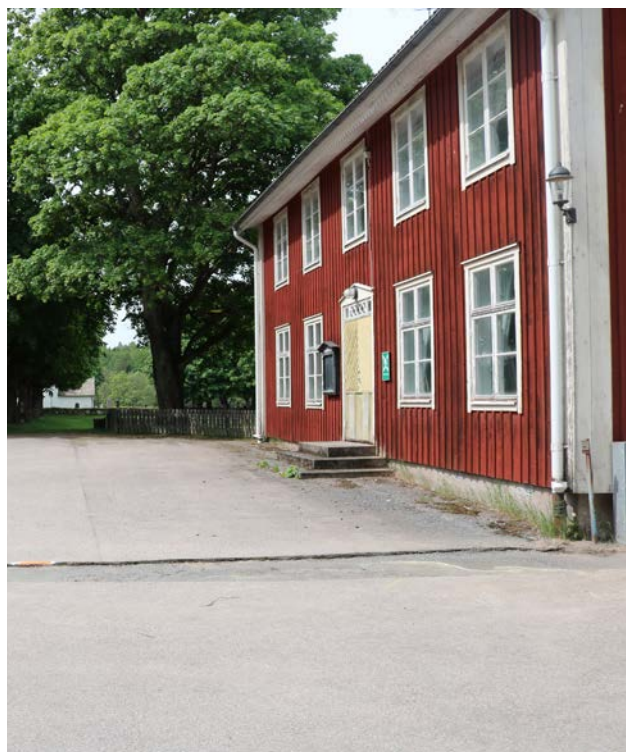
Kånna sockenstuga, centralt placerad i sockencentrat vid kyrkan.
