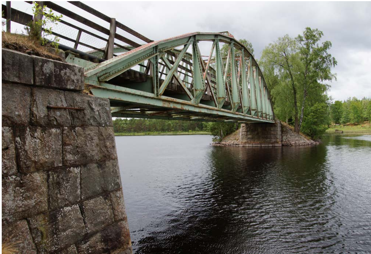
Den bevarade järnvägsbron över Fettjesundet används idag endast av gående och cyklister.
