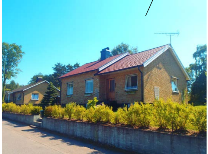
Sälgen 13, Sälgvägen 25 m.fl Sälgvägen kantas av villor i ett plan, uppförda under 1950- och 1960-talet. Byggnaderna har sadeltak och fasaderna är tegelklädda i ljusa kulörer. Utstickande murning kring fönster och dörrar förekommer. Sälgvägen 5 har en sido- och höjdförskjutet byggnadskropp, vilket är signifikant för detta årtionde.
