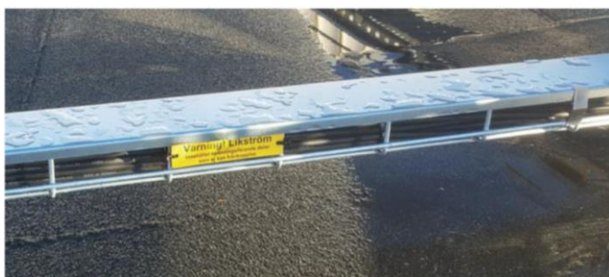
Figur 2. Exempel på skyltning för brytare och spänningsförande delar (Räddningstjänsten Storgöteborg, 2019). Gula skyltar är avsedda som allmän varning och röda skyltar är avsedda för räddningstjänsten.
